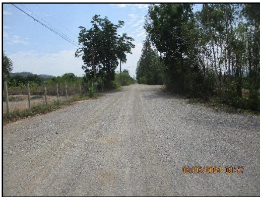
ภาพที่ 2.6 ถนนหินคลุกบดอัดแน่นภายในพื้นที่โครงการ
